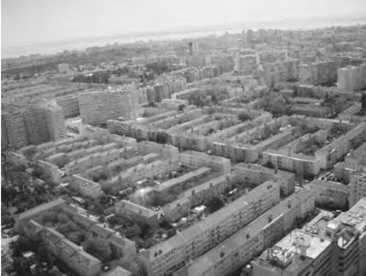
Fig. 1: Vista aérea do Bairro de Alvalade. Fonte: foto da autora
